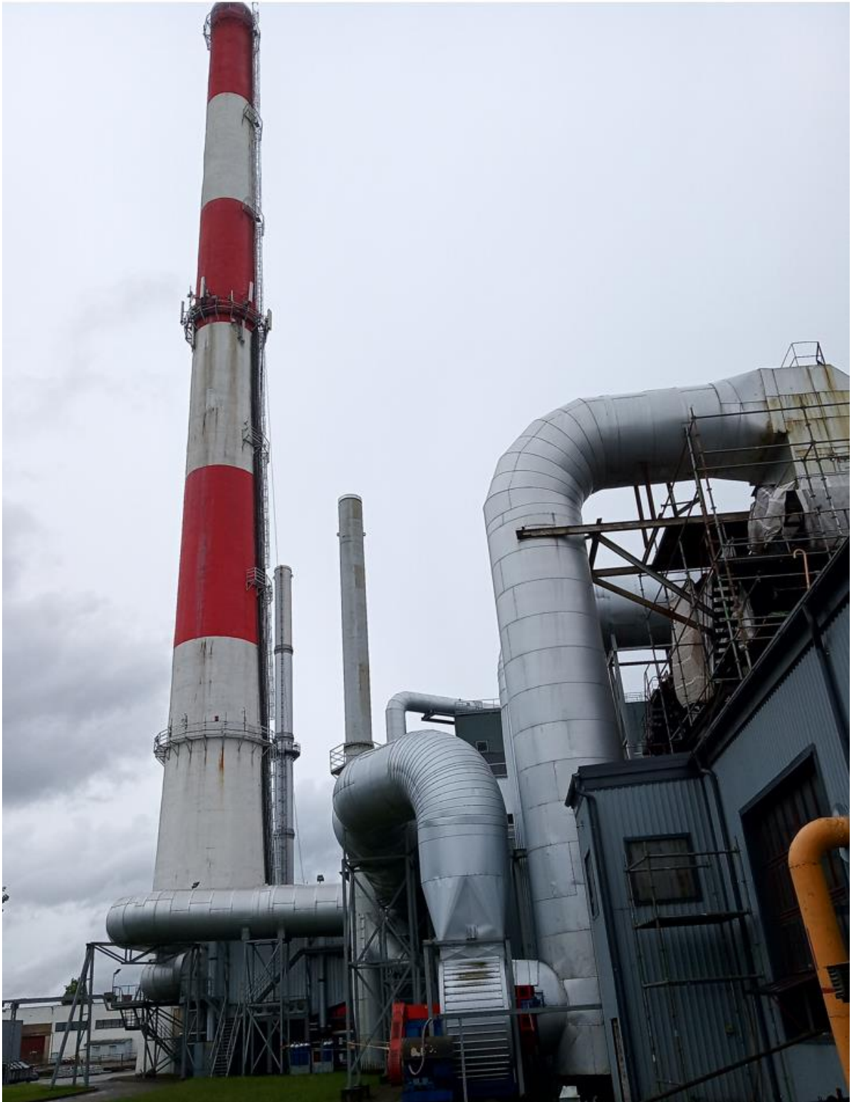
45 pav. Didžiausi pramoninės veiklos triukšmo šaltiniai mieste yra AB Šiaulių energija pietinės katilinės pastato išorėje esančios dūmsiurbės.
