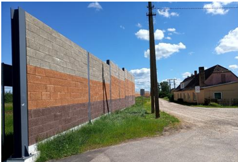
39 pav. Geležinkeliu pravažiuojančių traukinių triukšmo slopinimo užtvartos rytinėje miesto dalyje, Margių g. aplinkoje (ilgis 840 m, plotis 0,25 m., aukštis nuo 4 iki 8 m) ir vakarinėje miesto dalyje, Ragainės g. aplinkoje (ilgis 822 m, aukštis nuo 4 iki 6 m.).
