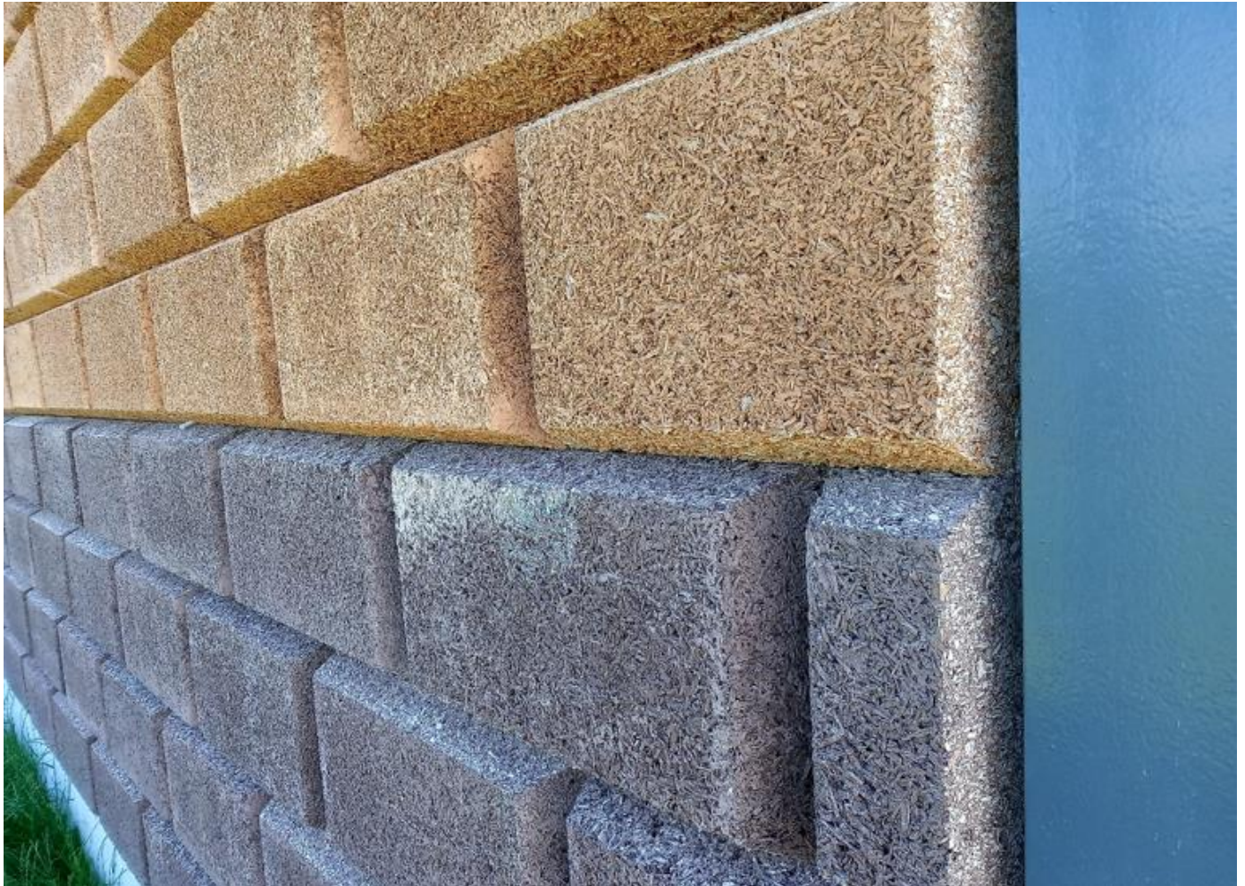
40 pav. Geležinkelio triukšmo slopinimo užtvarų konstrukciniai elementai (sienų laikančios konstrukcijos – kolonos su pamatais, užpildo elementai – montuojami triukšmo mažinimo blokeliai iš 90% spygliuočių medienos, 2 % cemento ir 8 % spec. mineralų mišinio, garso izoliacijos kategorija B3, oru sklindančio garso izoliacijos rodiklis DL_R 25\div 34 dB).
